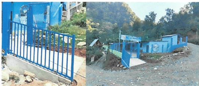
FOTO No.7 SE CONSTRUYÓ EL MURO QUE DA EL SOPORTE PARA LA RAMPA DE ACCESO FUNDIDA DE CONCRETO
