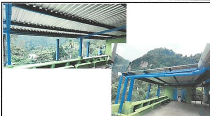
FOTO No.2 COMPLETAMENTE TERMINADA LA INSTALACIÓN DE LA ESTRUCTURA METÁLICA EN EL TECHO Y LA LÁMINA GALVANIZADA
