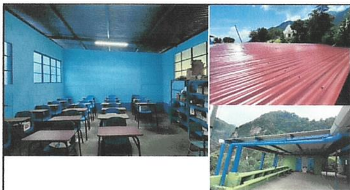
FOTO No. 9 LAS PAREDES QUEDARON DEBIDAMENTE PINTADAS ASÍ COMO LA LÁMINA EXISTENTE CON PINTURA DE ACEITE PARA PROTECCIÓN DE LA MISMA
