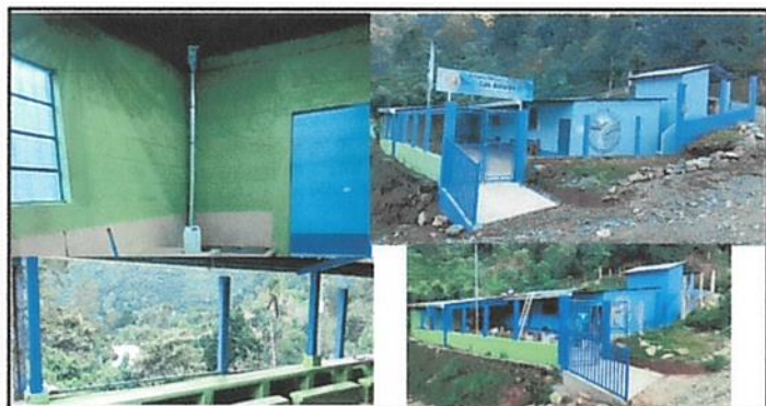
FOTO No.5 SE CONSTRUYERON LAS PAREDES NUEVAS EN LA COCINA Y SE SUSTITUYÓ LA MALLA GALVANIZADA
