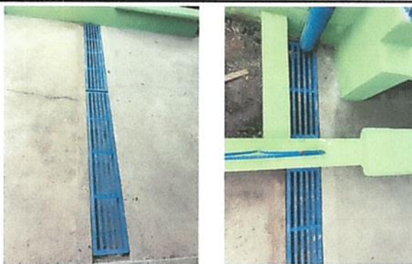
FOTO No.10 SE CONSTRUYÓ LA CUNETA PARA AGUA RECOLECCIÓN Y CONDUCCIÓN DEL AGUA PLUVIAL Y SE INSTALÓ UNA REJILLA DE METAL
