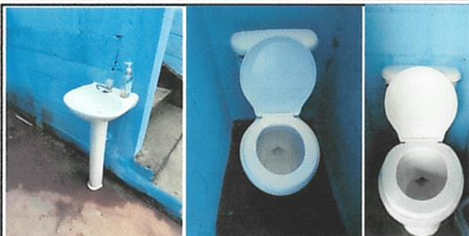
FOTO No. 1 ARTEFACTOS SANITARIOS (LAVAMANOS E INODORO) DEBIDAMENTE INSTALADOS Y PROBADOS
