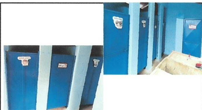
FOTO No.3 LAS PUERTAS DE LOS SERVICIOS SANITARIOS REPARADAS (3 UNIDADES) Y PUERTAS INSTALADAS NUEVAS (2 UNIDADES)
