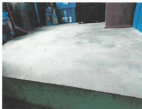
FOTO No.4 SE CONSTRUYÓ EL PISO DE CONCRETO CON UN ACABADO ALISADO EN LA COCINA
