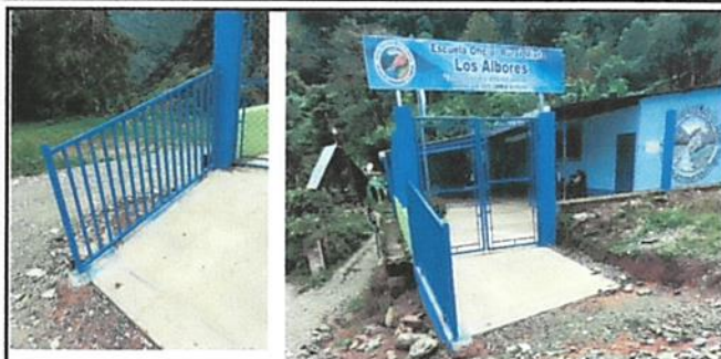
FOTO No.8 QUEDÓ FUNDIDA LA RAMPA DE ACCESO PARA FACILITAR EL INGRESO A LA ESCUELA
